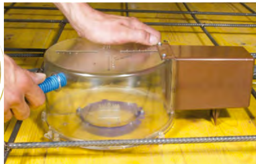
4. Installer les tubes après avoir enfoncé les entrées
