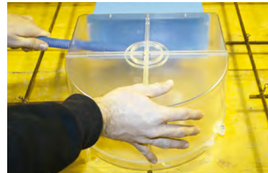
3. Installer les tubes après avoir enfoncé les entrées
