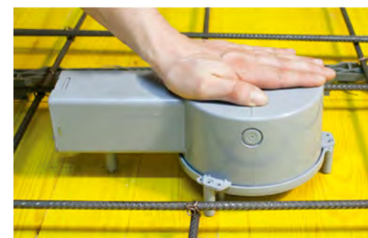
3. Refermer le boîtier et installer les tubes après avoir enfoncé les entrées
