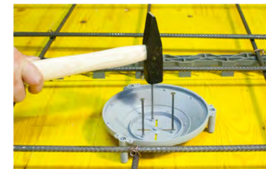
2. Clouer la partie inférieure au coffrage
